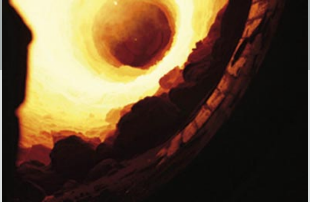
Bild 1: Innenansicht eines Drehrohrrofens im Betrieb.
