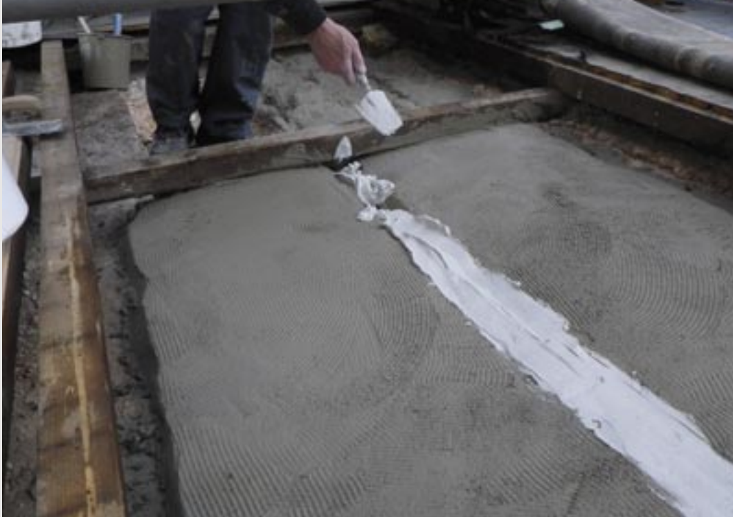
Bild 6: Einbau des Estrichs zur Egalisierung des Untergrundes. Die textilbewehrte Rissbandage wurde im Anschluss an die Nachbehandlung mittels Lamiertechnik frisch-in-frisch auf den Estrich appliziert.
