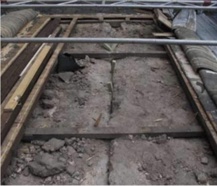
Bild 2: links: Ansicht des Risses – Aufnahme vom Dach des Sechszehneckes aus vor der Schutzmaßnahme; rechts: Rissverlauf im Grundriss.
