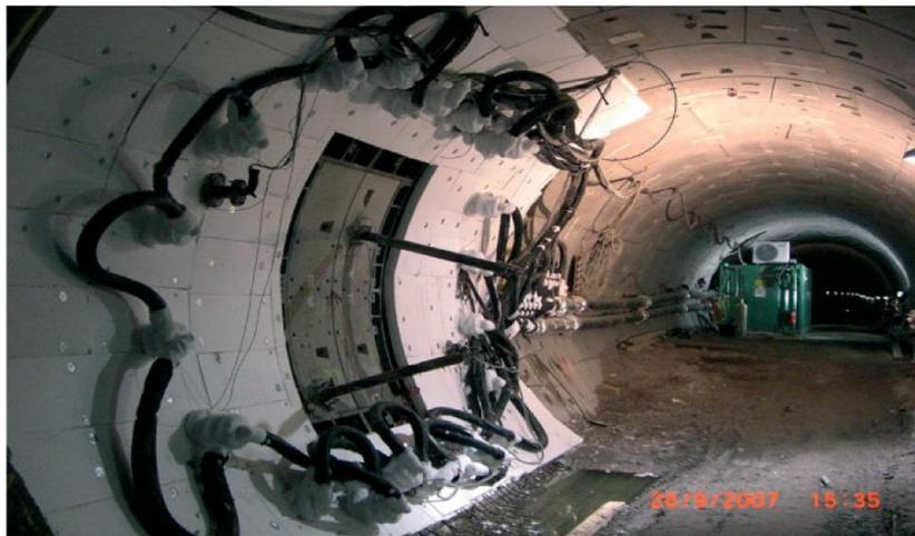
**Bild 6.16** Querschlagvereisung mit mobilen Kühlaggregaten (Wenke & Willner 2008)
