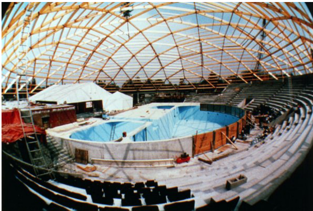
Rechteckprofile an Zylinderknoten 11
