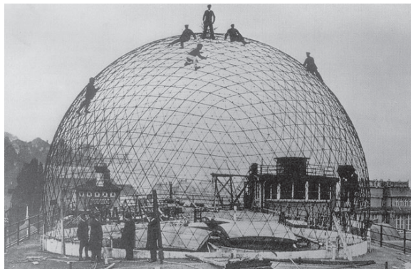
Die Kuppel von W. Bauersfeld über dem Zeiss-Planetarium in Jena. Die Stabstruktur ist die Bewehrung der Stahlbetonkuppel 2
