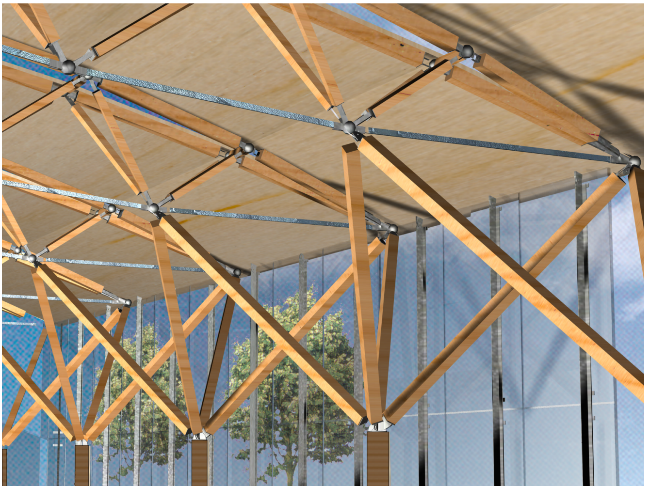
Ausstellungspavillon, Ausschnitt Deckenuntersicht mit baumstützenförmiger Auflagerung
