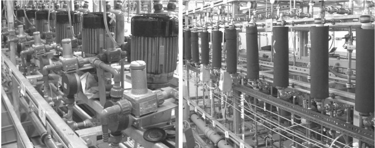
Abbildung 2.6: Versorgungskeller der AMOVA 2005; links: Rückansicht, Sera-Pumpen; rechts: Frontansicht, Flow-Meter und Zuleitungen der Applikations-Lösungen
