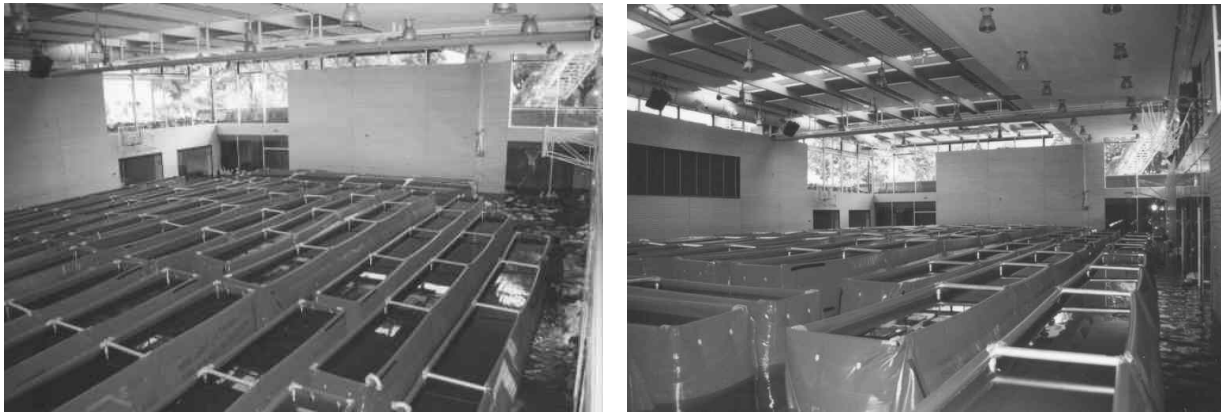
Abbildung 1.4: Gegengewicht aus Behältersystemen und Flutung der Bodenplatte als Sofortmaßnahme gegen das Aufbrechen der Bodenplatte in der Turnhalle des St.-Benno-Gymnasiums durch unterirdisches Hochwasser (St.-Benno-Gymnasium 2002)
