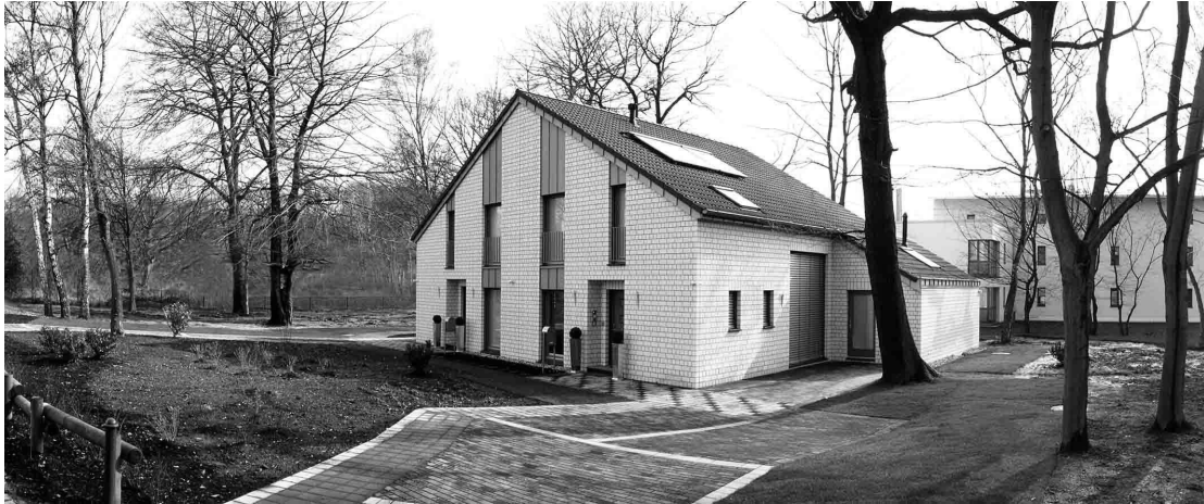
Abbildung 2.4: inHaus1 am Fraunhofer IMS in Duisburg. (Quelle: [Fra09])
