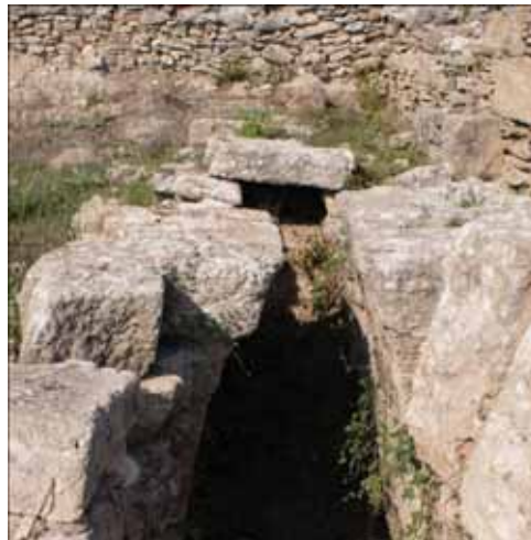
Abbildung 1.1-1: Überreste eines Abwasserkanals im Ruinenfeld von Ugarit in Syrien aus dem 2. Jahrtausend vor Christus. Der Kanal besaß bereits Decksteine und führte unter bebautem Gebiet hindurch.
