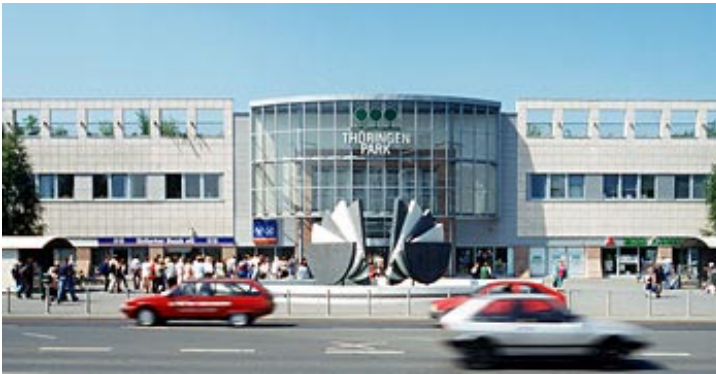
Abb. 2 Gebäude TP Vorderansicht
