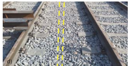
Abbildung 4-16 a) Bereich Koppelfuge ohne Schwellen und Schienen, b) Einbau Schwellen und Schienen c) Unwuchterreger auf Überbau 1 d) Fugenbereich im fertigen Zustand
