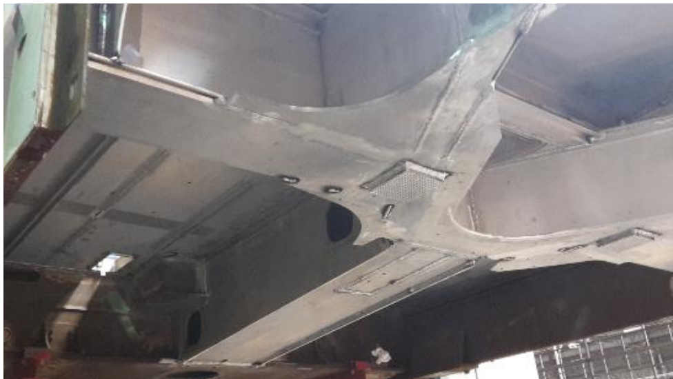
Abbildung 11: Die fertige Schweißreparatur am Wagenkasten, Bildrechte: DB Systemtechnik N. Sokol
