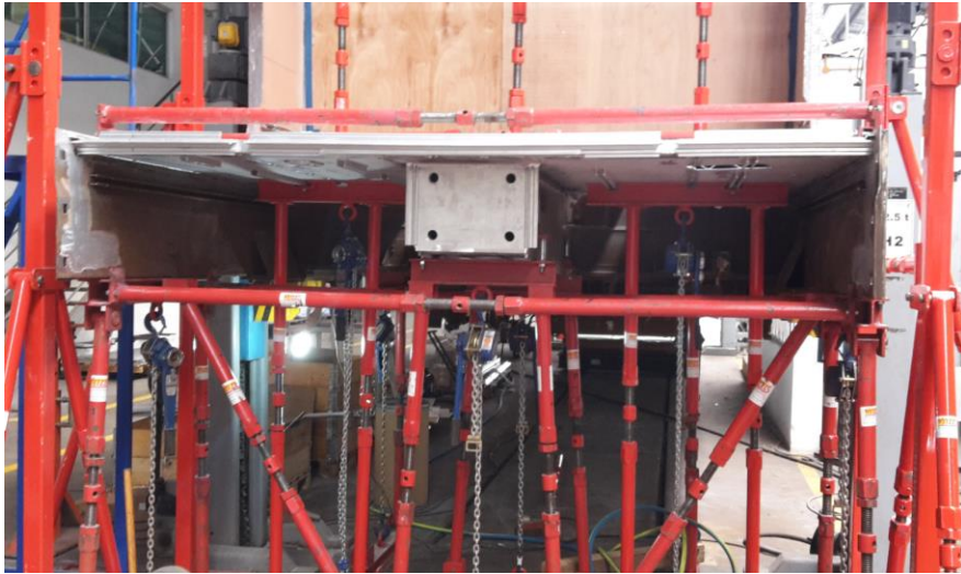
Abbildung 10: Eindrücke von der Abspannung während der Reparatur, Bildrechte: DB Systemtechnik, M. Bretschneider
