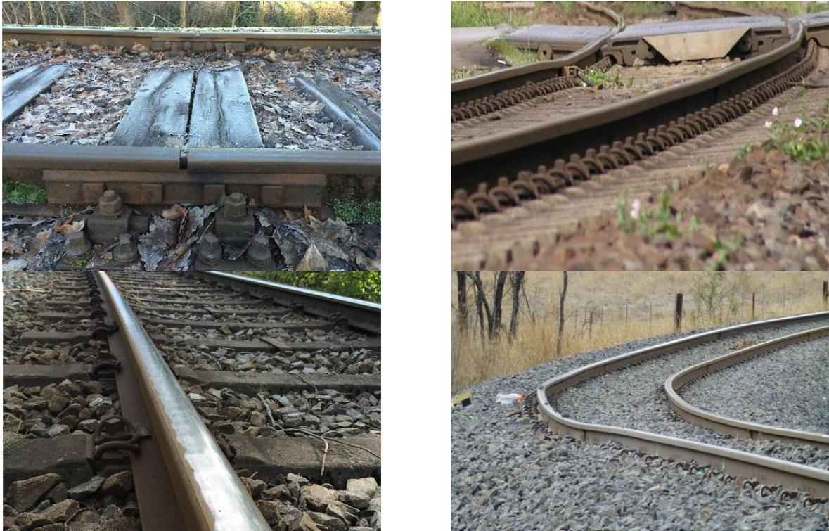
Abbildung 9: Gleislagefehler, die mit Fahrbahn-Zustandsüberwachungssystemen erfasst werden können (links oben: Schienenstöße und -lücken, rechts oben: vertikale Gleislageabweichungen, links unten: Schienenriffel, rechts unten (Quelle: [https://www.atsb.gov.au/media/4260904/ro2013012\\_fig6.jpg](https://www.atsb.gov.au/media/4260904/ro2013012_fig6.jpg)): Gleisverwindungen)
