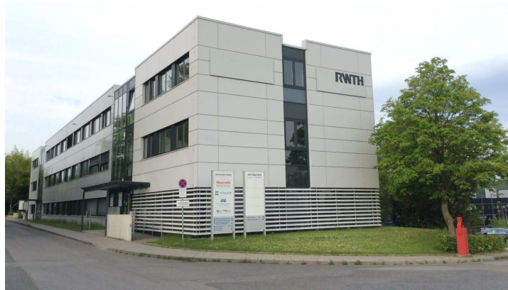
Abbildung A.7: Anwendungsbeispiel 5.0, reales Bürogebäude in der Mathieustraße 30, 52074 Aachen.
