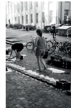
Abb. 4-8: Schalung der Sockelplatten vor Ort
