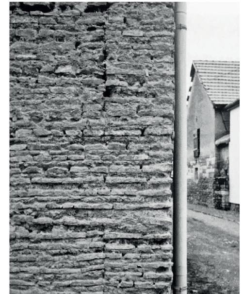
Abb. 3-43: Eingestampfte Ziegelleisten an einer Scheune in Jügendorf (Sachsen-Anhalt)
