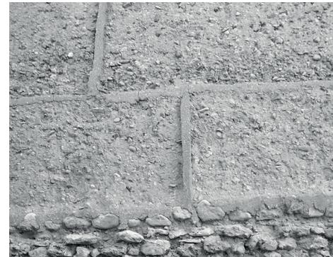
Abb. 3-38: Tapia con juntas reforzadas
