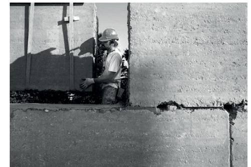
Abb. 3-10: Versatz der Elemente auf der Baustelle (Fa. Lehm Ton Erde)
