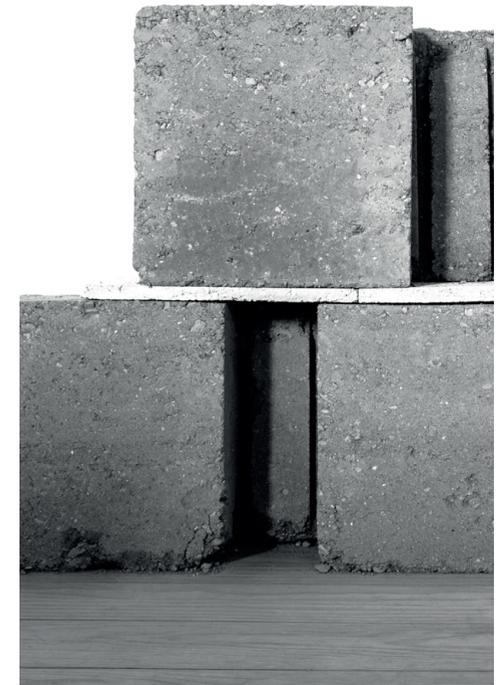
Abb. 4-53: Vorgefertigte, getrennt vom Lehmstein gefügte Erosionsbremse (Mock-Up)
