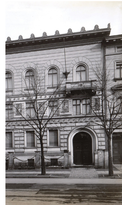
Wohnhaus Möhrner am Lützowplatz, Berlin-Tiergarten, um 1910 mit dem Wohnhaus Jordan am rechten Bildrand Fotografie unbekannt, Architekturmuseum der TU Berlin
