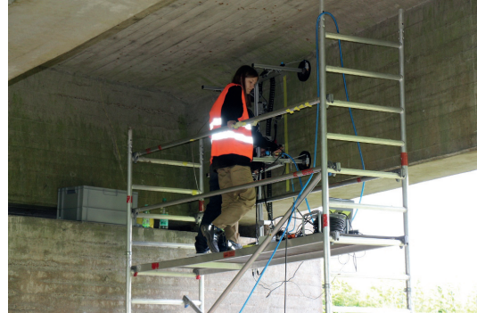
Abbildung 7.7: Ultraschall-Echo-Messung an der Leinebrücke
