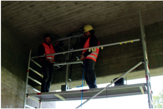
Abbildung 7.6: Anbringen des Scanners an die Leinebrücke
