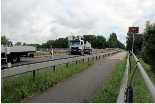
Abbildung 7.1: Fahrbahn mit Rad- und Fußweg der Leinebrücke
