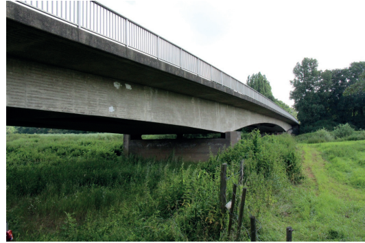
Abbildung 7.2: Seitenansicht der Leinebrücke in Schwarmstedt
