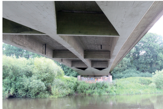
Abbildung 7.3: Plattenbalken der Leinebrücke im mittleren Spannfeld in der Ansicht von unten
