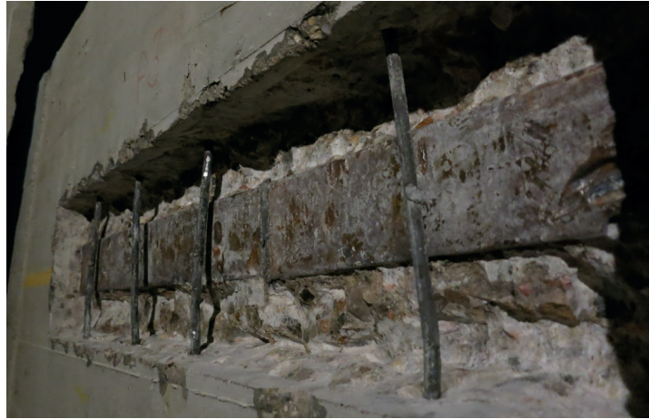
Abbildung 7.17: Freigelegter rechteckiger Spannkanal der Leinebrücke
