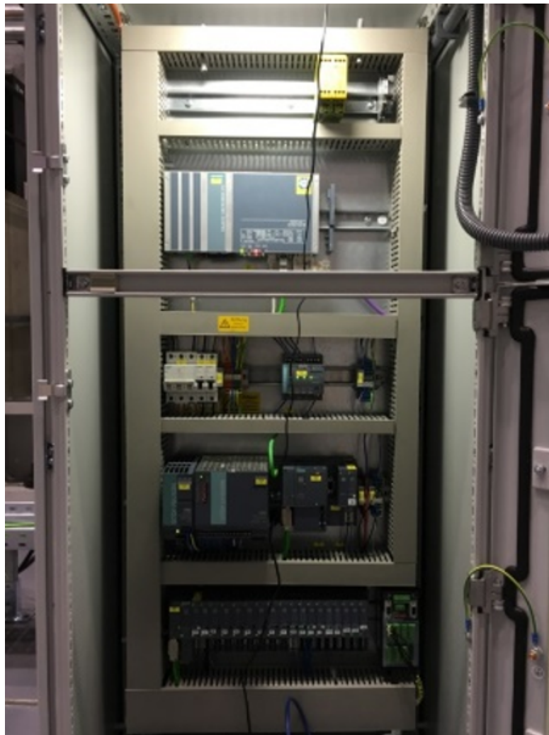
Abb. 3.8: Schaltschrank der WEA Automatisierung im Prüffeld mit Haupt- und Pitchsteuerung
