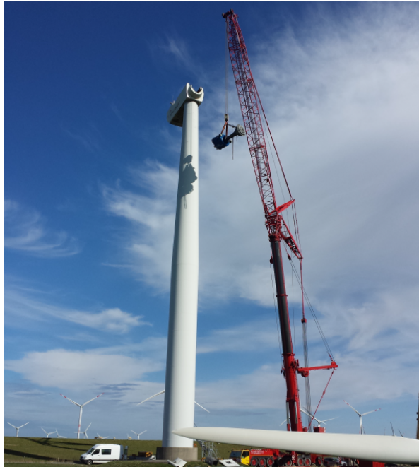
Abb. 3.1: Deinstallation der ursprünglichen Windenergieanlage nordwestlich von Husum an der Nordsee [81]
