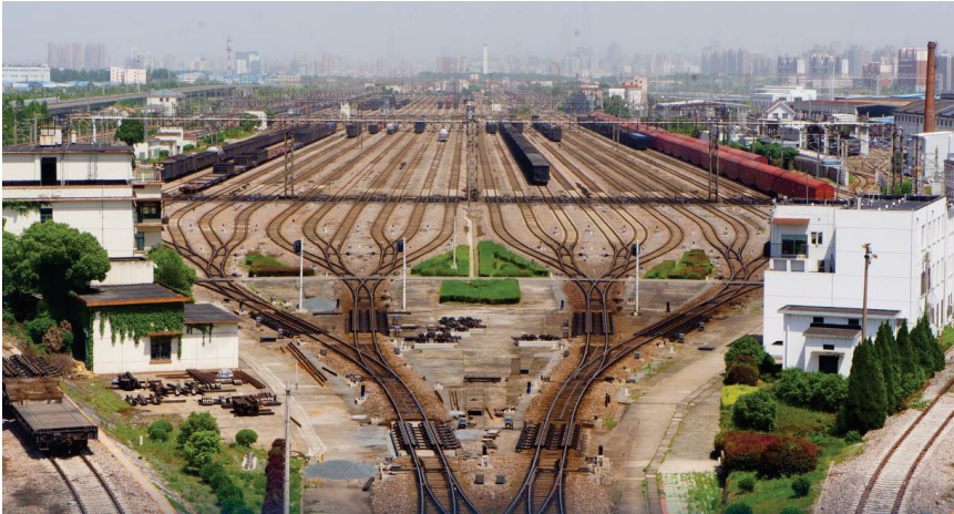
Abb. 2.10: Richtungsgruppe des Rangierbahnhofs Nanxiang nordwestlich von Shanghai, China [MNXANL, CC BY-SA 4.0]
