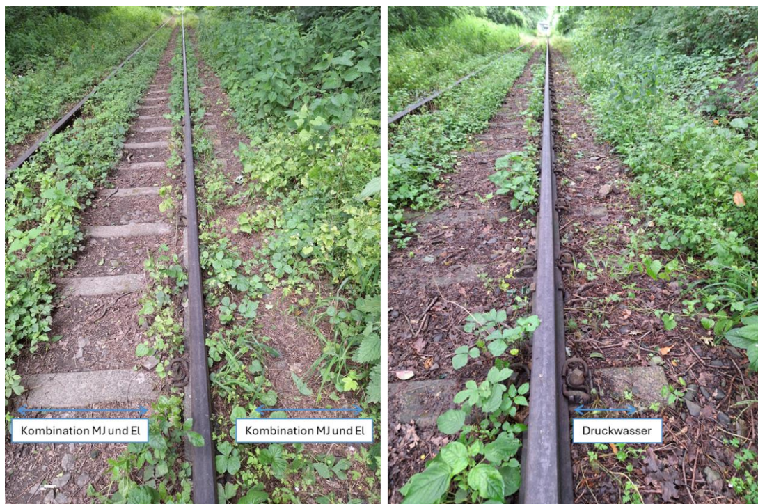
Abbildung 29: Links: Großflächige Behandlung mit dem MJ und El (noch ohne Druckwasser). Rechts: Bereich zusätzlich mit Druckwasser entlang der rechten Schienenaußenseite.
