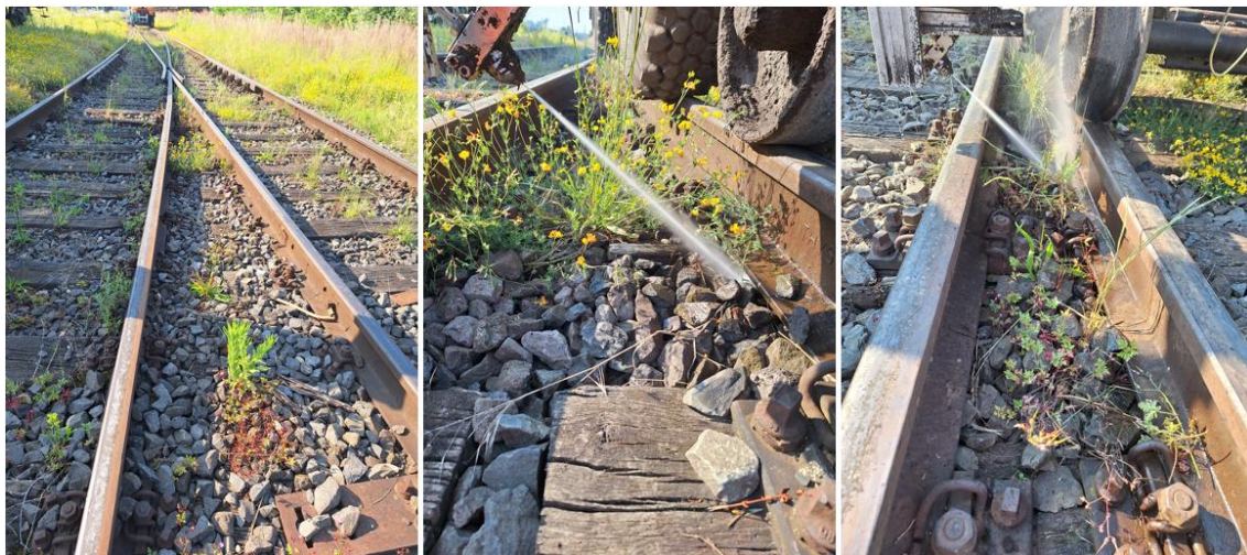
Abbildung 28: Einsatz des Druckwasserstrahls im Weichenbereich.
