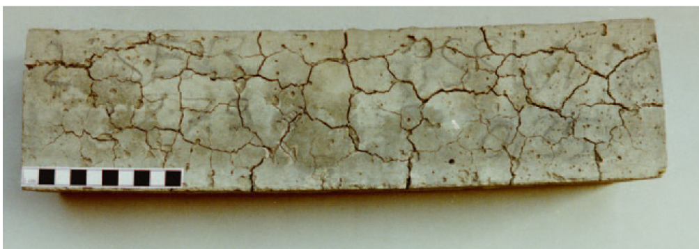
Abbildung 3: Geschädigter Betonprüfkörper mit Netzzissen und Verformungen in Folge von Ettringitbildung 24
