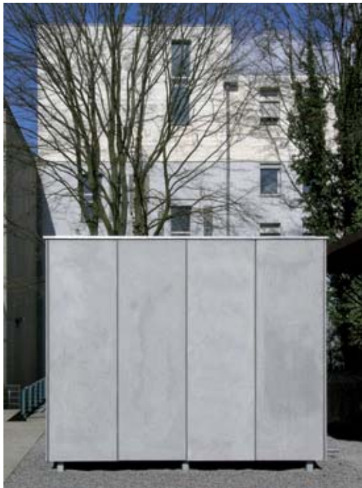
Das Texmodul auf dem Campus der RWTH Aachen ist ein Projekt aus dem Sonderforschungsbereich Textilbewehrter Beton
