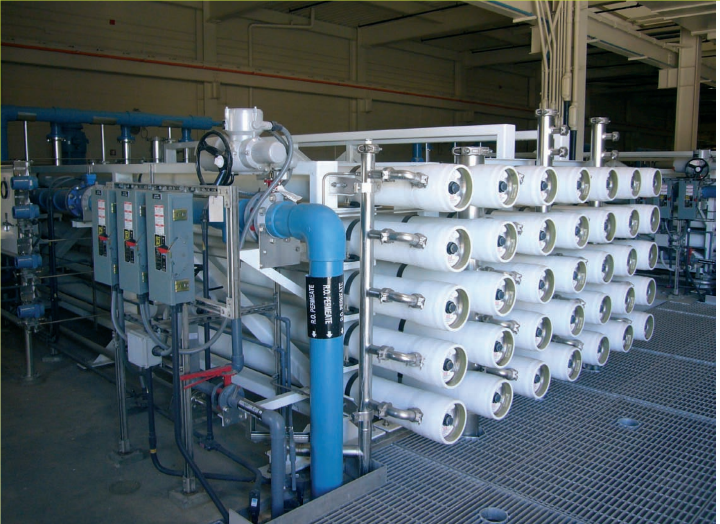
Bild 3: Umkehrosmose-Block der Wasserrecyclinganlage in Scottsdale, Arizona, USA.
