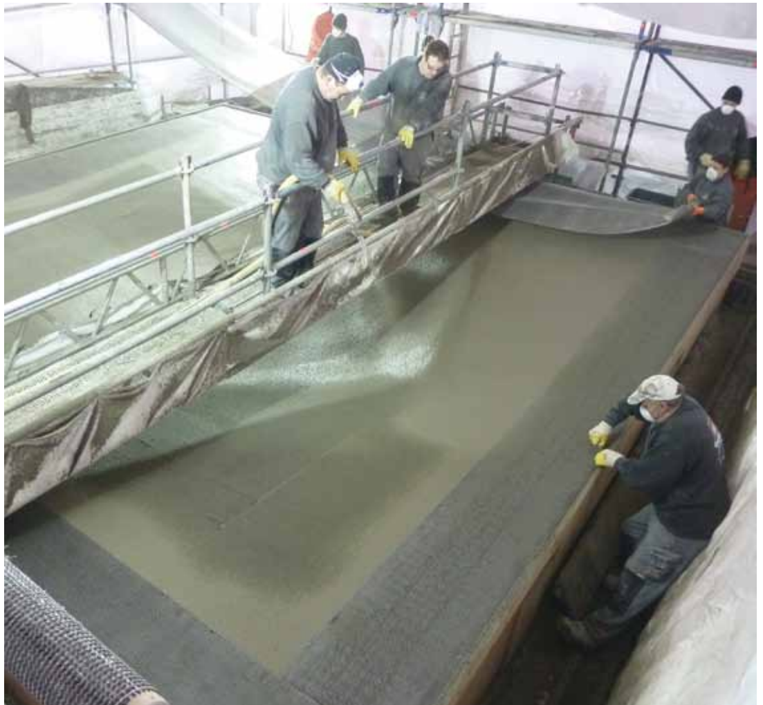
Bild 3: Lagenweise Herstellung der Textilbetonschalen in Spritzbetonbauweise. Foto: Institut für Massivbau
