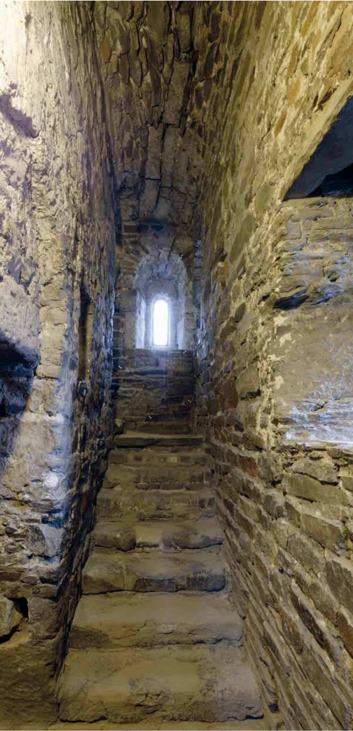
Bild 4: Treppeaufgang im Granusturm. Foto: Robert Mehl
