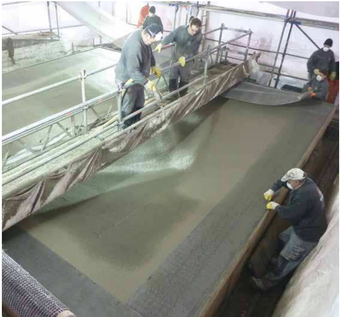
Bild 3: Lagenweise Herstellung der Textilbetonschalen in Spritzbetonbauweise.
