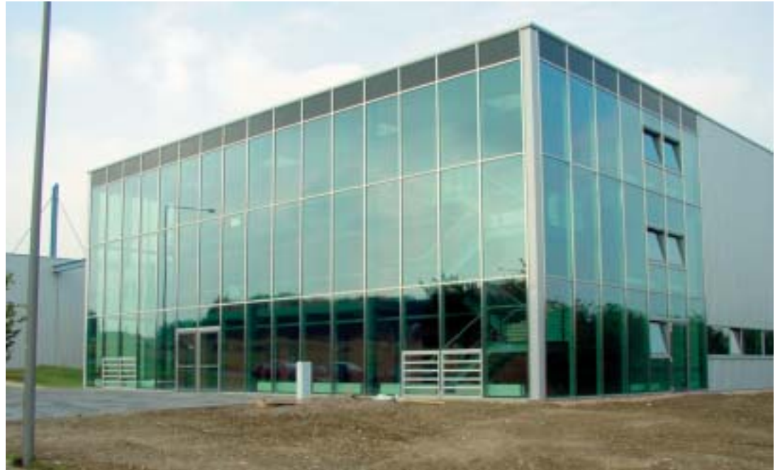
Bild 1: Der Neubau des Zentrums Metallische Bauweisen (ZMB).
