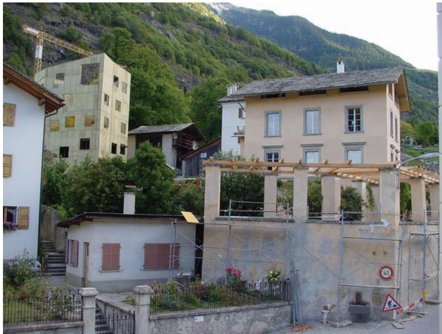
Abbildung A.3.1: Außenansicht des Altbaus und des Neubaus (im Rohbau) der Villa Garbald.
