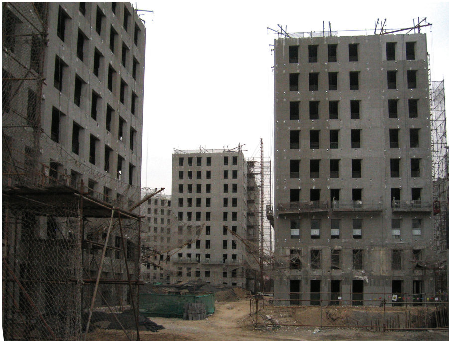
Abbildung A.4.1: Außenansicht des Projektes ‚ShangdiMOMA‘ von Baumschlager-Eberle Architekten im Bauzustand.
