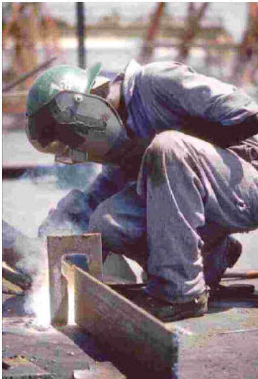
Abbildung 2-11: Manuelle Profilmontage
