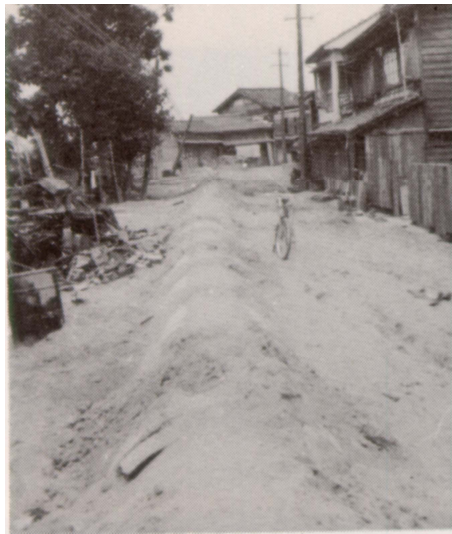
Bild 3.11: Aufgeschwommene Rohrleitung (Gesamtansicht und Detail).
