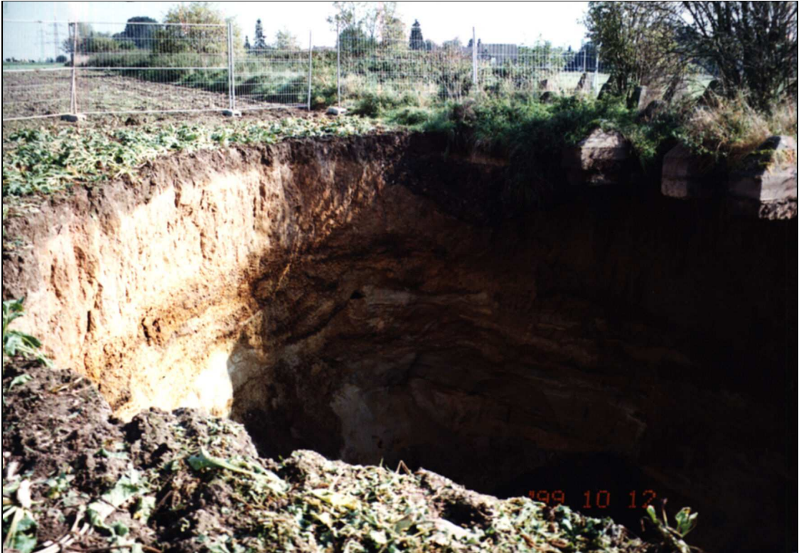
Abb. 19: Tagesbruch Mühlenbach in Herzogenrath-Pannesheide (BERGVERWALTUNG DÜREN, 12.10.1999)
