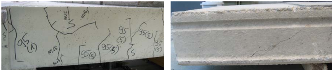
Bild A 2.157: Bruchbilder des Ringankers (links) und der ausgebauten Platte 6 (rechts) in Versuch 7
