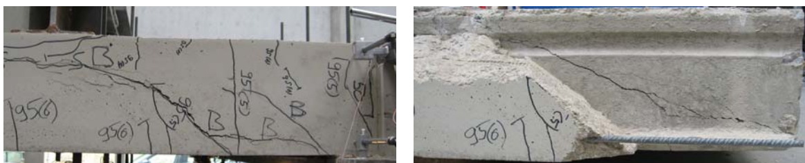
Bild A 2.158: Bruchbilder des Ringankers (links) und der ausgebauten Platte 10 (rechts) in Versuch 7
