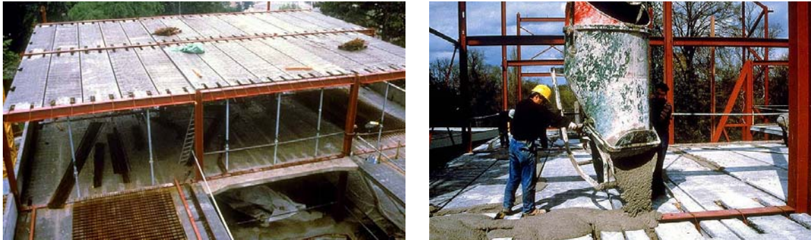
Bild 2.15: Stahlskelettkonstruktion mit Ergänzung durch Spannbeton-Fertigdecken
