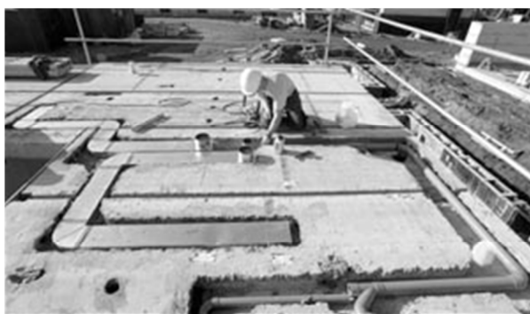
Bild 2-14: links: VBI Leidingvloer /VBI10/; rechts: VBI Klimaatvloer /VBI07/
