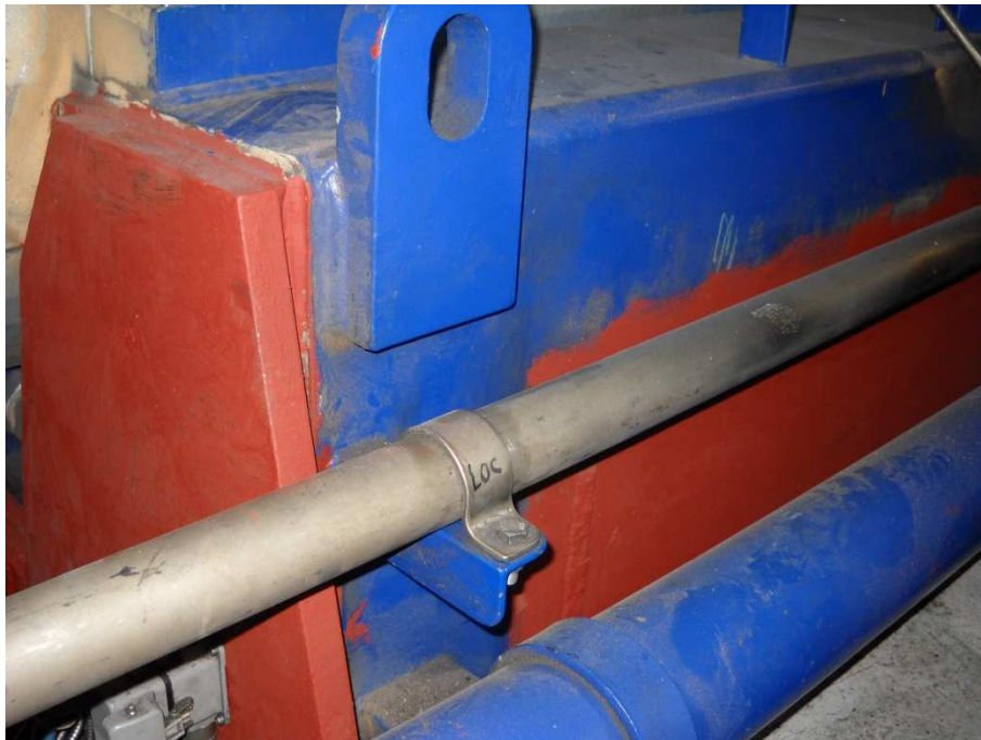
Abbildung 5-1: Anbringen von zusätzlichen Stahlplatten
