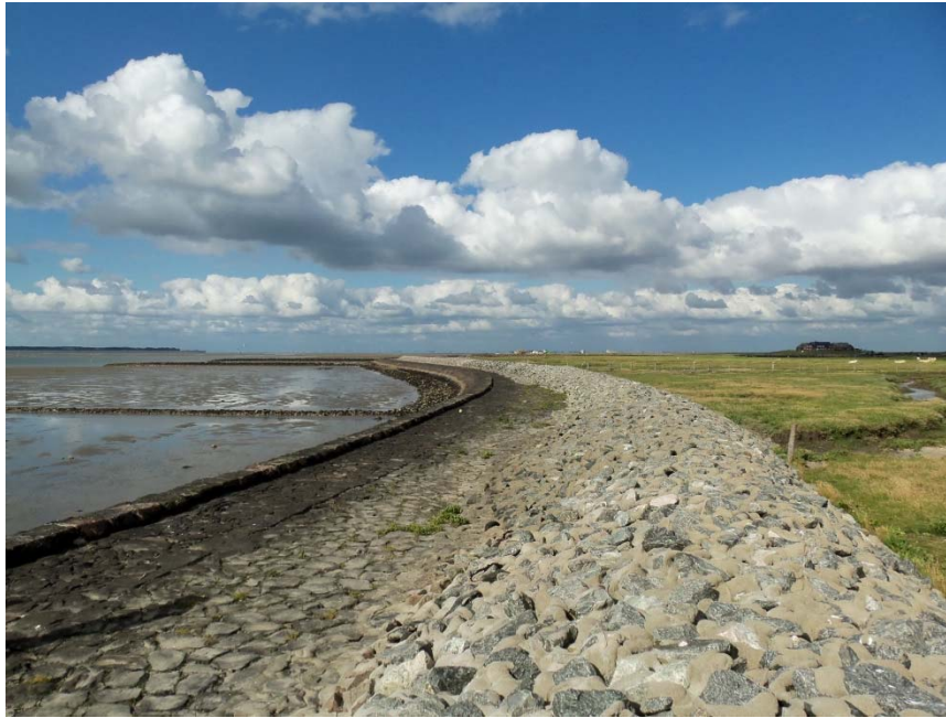
Abbildung 4.4: Raustreifen mit kolloidaler Vermörtelung auf Langeneß und vorgelagertes Deckwerk
