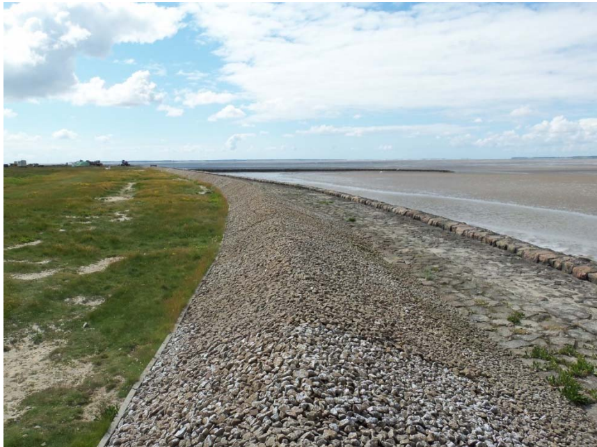
Abbildung 4.5: Elastocoast®-Raustreifen auf Langeneß
