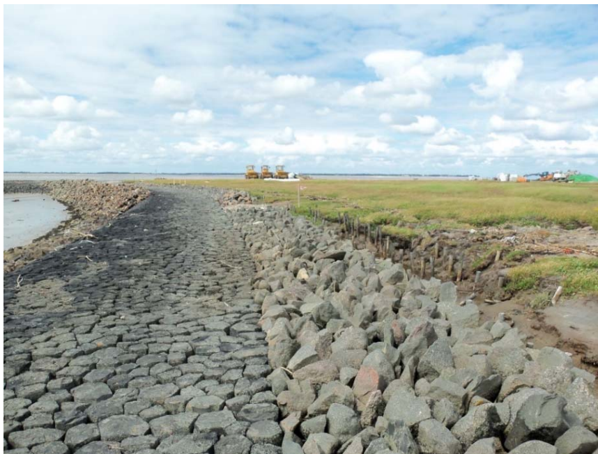
Abbildung 4.3: Setzsteinraustreifen auf Langeneß mit vorgelagertem Deckwerk
