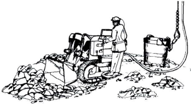
Abbildung 27: Ladearbeit auf der Schachtsohle mittels Wurfschauffellader. 126
