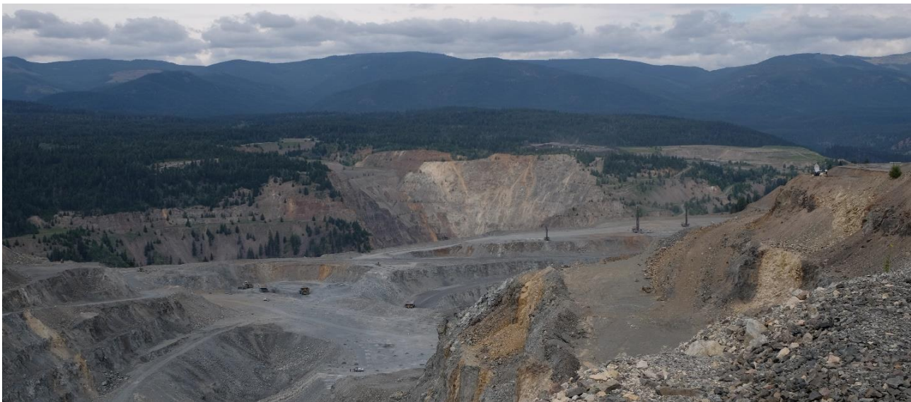
Abbildung 32: Tagebau Copper Mountain
