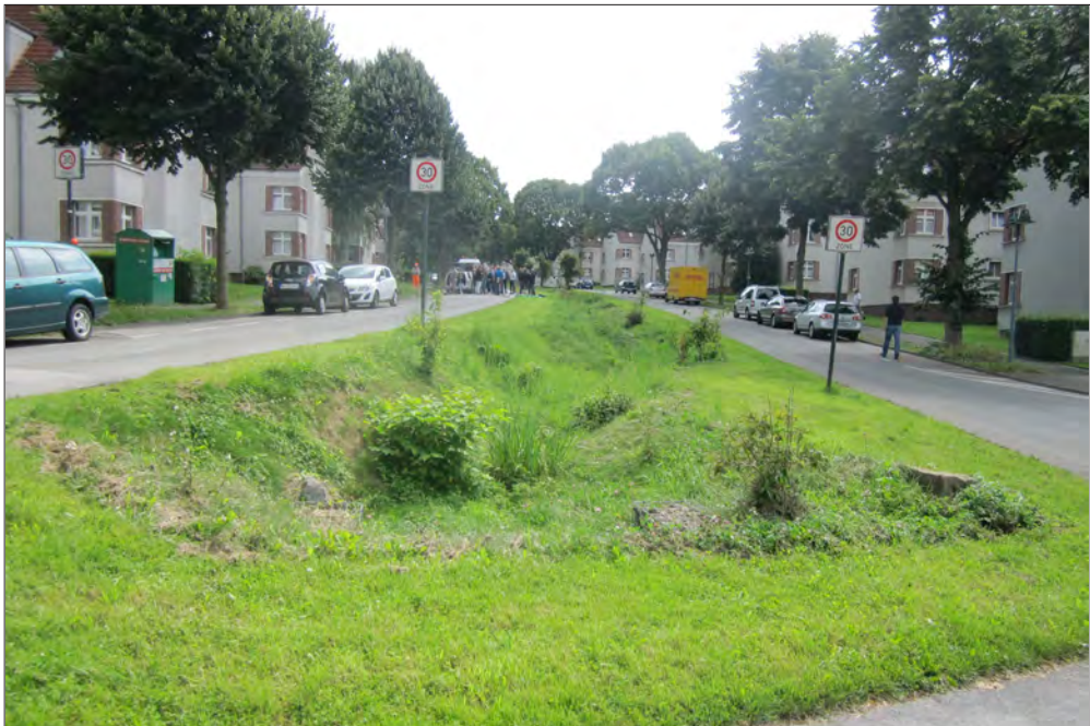
Bild 1: Versickerungsmulde in Solingen 2015 Foto: Institut für Stadtbauwesen und Stadtverkehr
