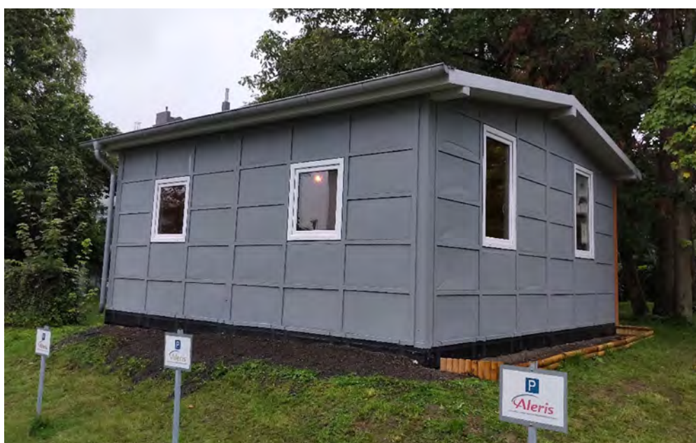
Bild 1: Prototyp des PMF-Hauses am Institut für Textiltechnik.
