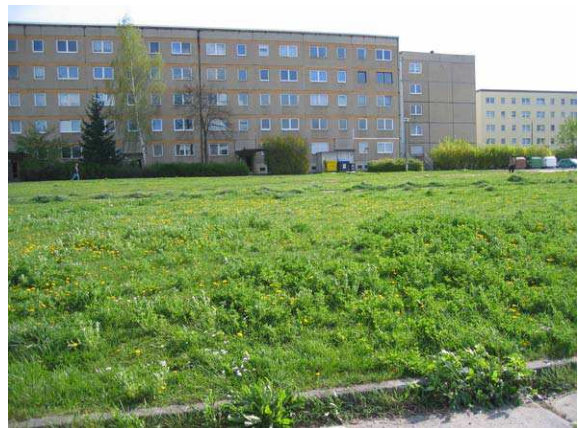
Abb. 15: Begrünte Abrissfläche in Halle (Saale) Foto: PT
