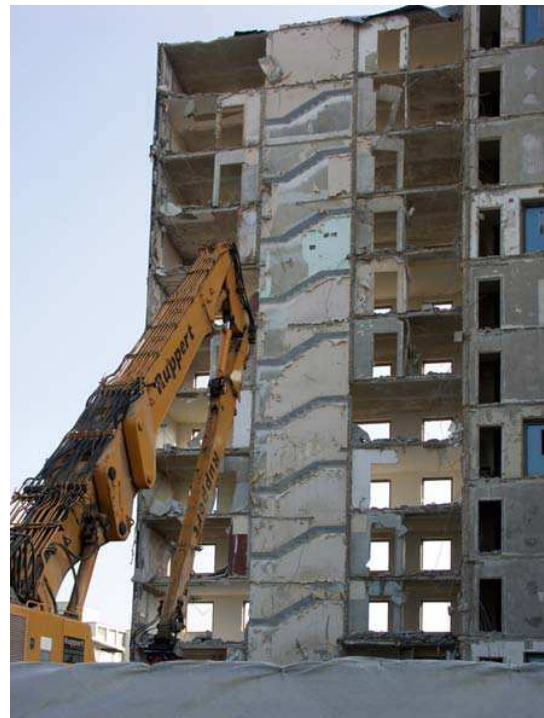
Abb. 13: Rückbau in Halle (Saale) Foto: PT
