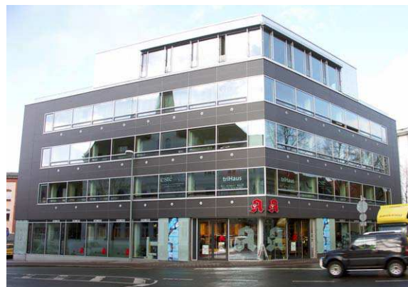
Abb. 12: Neubau in Amsberg-Neheim Foto: PT
