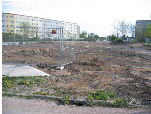
Abb. 14: Brachfläche nach Abriss in Halle (Saale) Foto: PT
