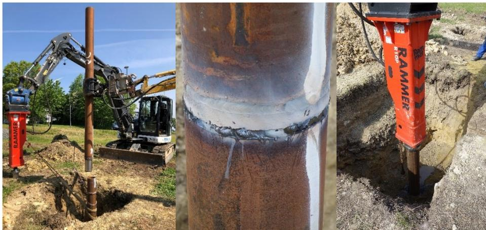
**Abbildung 5-8: Ramm- und Schweißarbeiten vor Ort, links: Positionierung der Pfahlelemente, Mitte: Verbindung durch Schweißen, rechts: abschließendes Rammern**
