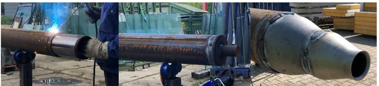
**Abbildung 5-6: Schweißarbeiten, links: Innenmuffe an Rohrelement, Mitte: Felsschuh als unterer Pfahlabschluss, rechts: konischer Aufsatz**
