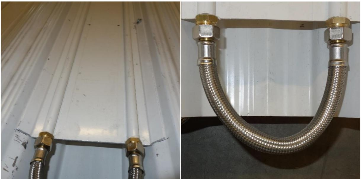
**Abbildung 3-11: Detailaufnahmen des Demonstrators, links: integrierte Strahlungsplatte, rechts: Anschluss mittels Stahlflexleitung**
