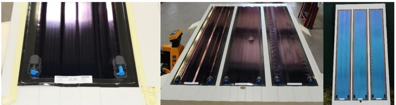
**Abbildung 4-13: Angebrachte OPV-Folie, links: Detail der vollflächigen Verklebung, Mitte: Unterschiede in der Verklebung, rechts: Ansicht bei Tageslicht**
