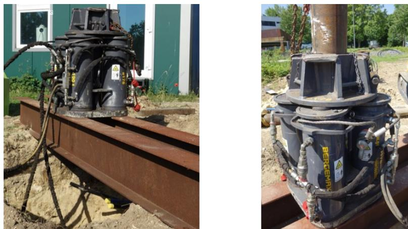
**Abbildung 5-22:** Ziehen eines Stahlrohres aus dem Baugrund, links: Zugerät auf Unterkonstruktion, rechts: Zugerät mit eingespanntem Stahlrohr
