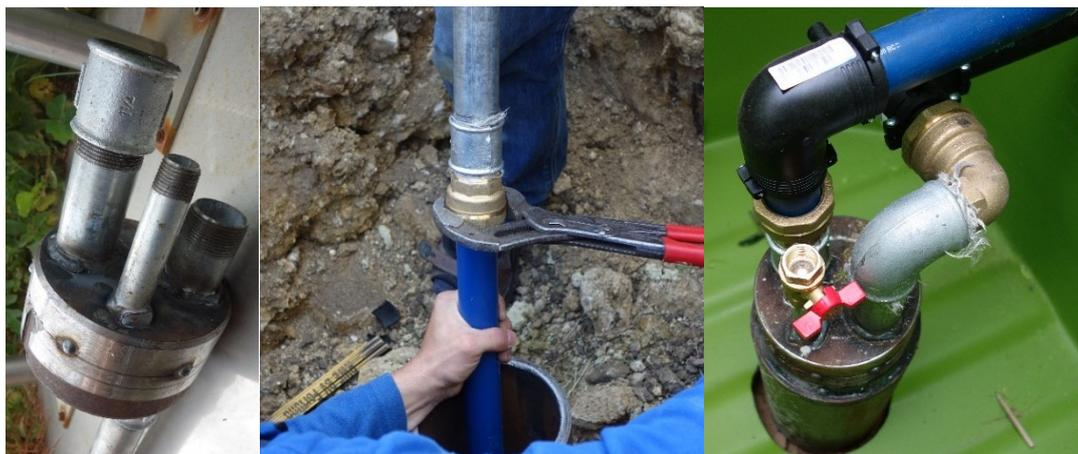
**Abbildung 5-10: Koaxialsondenkopf, links: Detail vor der Montage, Mitte: Anschluss an die Sonde, rechts: Anschluss an die Anbindeleitungen im Schacht**
