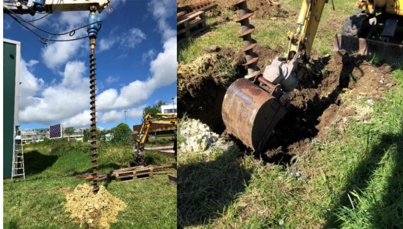
**Abbildung 5-7: Bohr und Baggerarbeiten, links: Vorbohrung mittels Bohrschnecke, rechts: Vorbereitungen für den späteren Schachteinbau**
