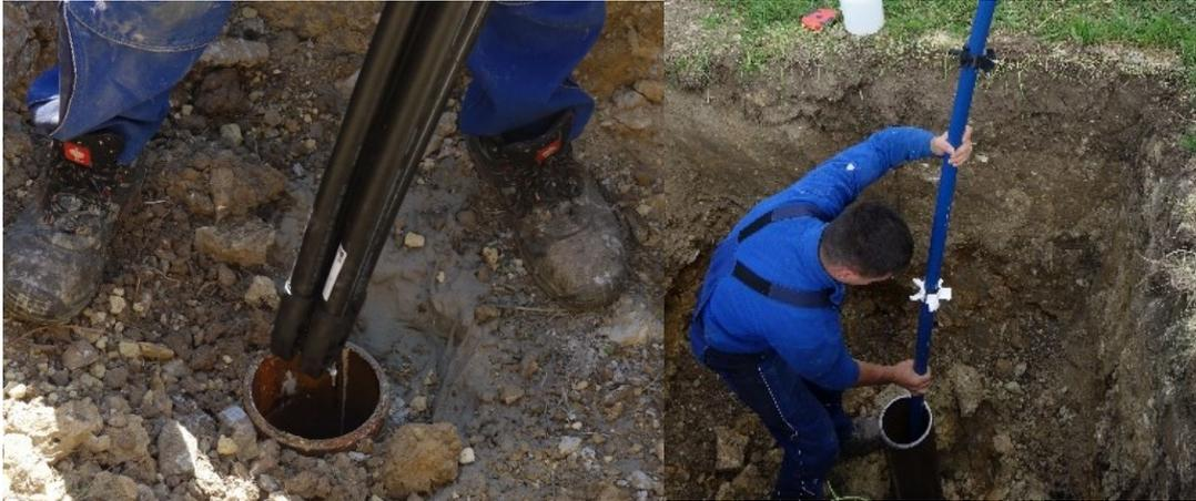
**Abbildung 5-9: Einführen der Sonden in die eingerammten Pfähle, links: Doppel-U-Sonde, rechts: Koaxialsonde**
