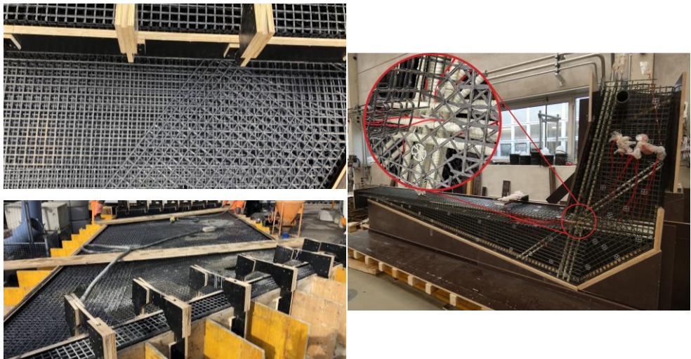
Bild 7 Bewehrungskorb des Überbaus der ersten Straßenbrücke in Gaggenau (links oben, Foto: Sergej Rempel); Betonage mit nachträglich geschnittener Einbring- und Verdichtungsöffnung (links unten, Foto: Sergej Rempel); Bewehrungskorb und Knotendetail des Großversuchskörpers für die Brücke Ludwigsburger Straße (rechts, Foto: IMB RWTH, aus [11])
