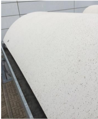
Bild 10 Biologischer Bewuchs in oberflächlichen Schwindrissen an Beton-Tonnenschalen mit ungetränkter Carbonbewehrung (links, Bild: IMB RWTH); Stirn- und unterseitige Verunreinigungen durch kapillare Saugwirkung der Carbonmatten und Verdunstung (rechts, Bild: IMB RWTH)
