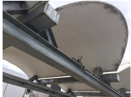
Bild 10 Biologischer Bewuchs in oberflächlichen Schwindrissen an Beton-Tonnenschalen mit ungetränkter Carbonbewehrung (links, Bild: IMB RWTH); Stirn- und unterseitige Verunreinigungen durch kapillare Saugwirkung der Carbonmatten und Verdunstung (rechts, Bild: IMB RWTH)
