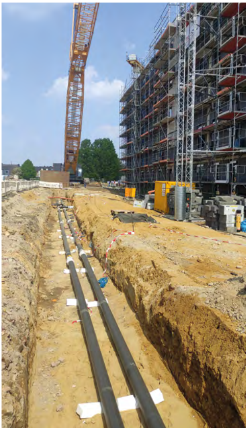
Bild 5: Verlegung von Rohrleitungen für ein kaltes Wärmenetz im Rahmen des Reallabors „TransUrban.NRW“ Foto: Lehrstuhl für Gebäude- und Raumklimatechnik
