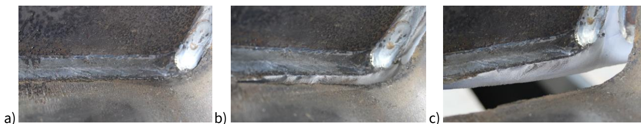
Bild 4-34: Rissentwicklung des Prüfkörpers S0.0-5: a) Haarriss, b) Riss durch die Flanschdicke und c) Bruch des Flansches, siehe auch [139]
