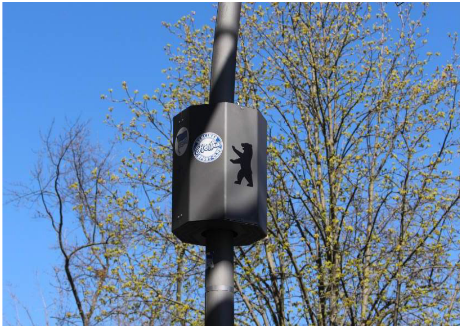
Abbildung 10 Laterne mit einfügender Mobilfunktechnik in Berlin Eigenes Foto
