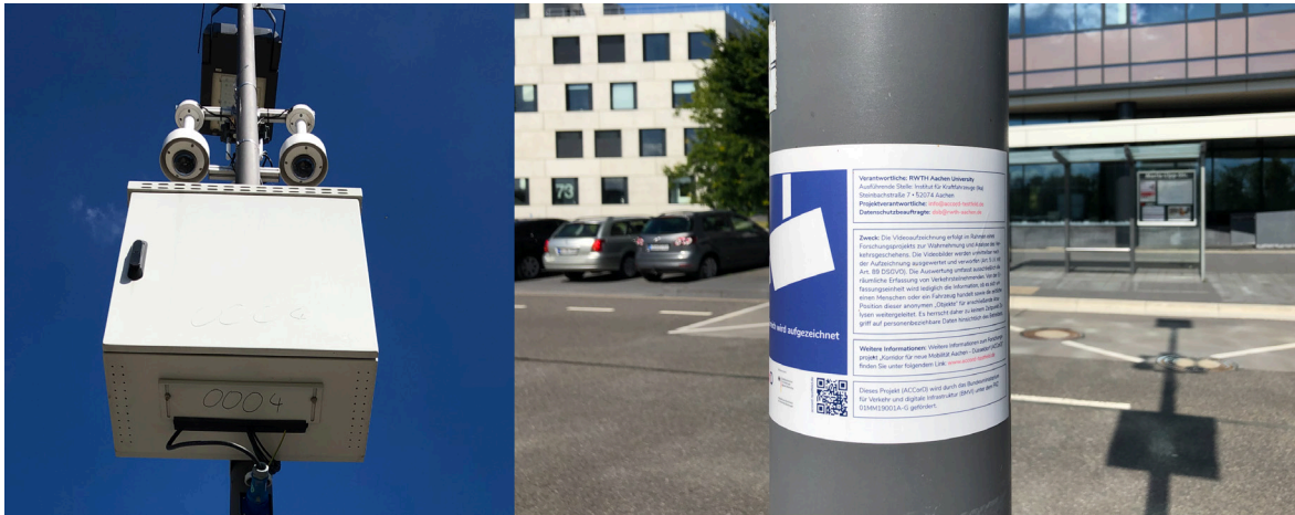
Abbildung 60 Technische Infrastruktur auf dem Campus Melaten und deren Erläuterung Eigene Aufnahmen
