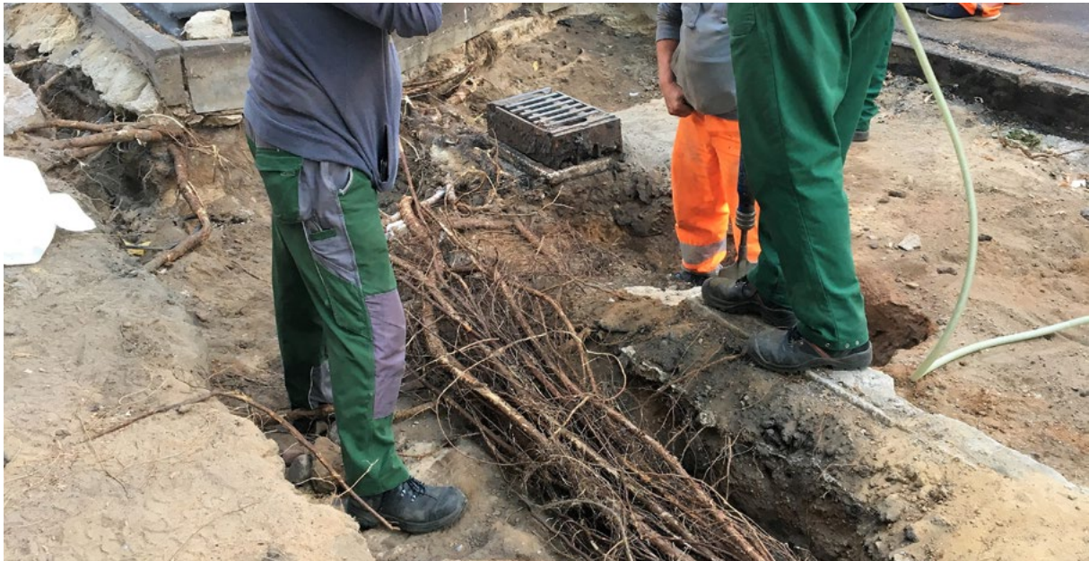
Abbildung 1: Schutz des Wurzelbündels einer Rubinie. Quelle: Christine Neubert.
