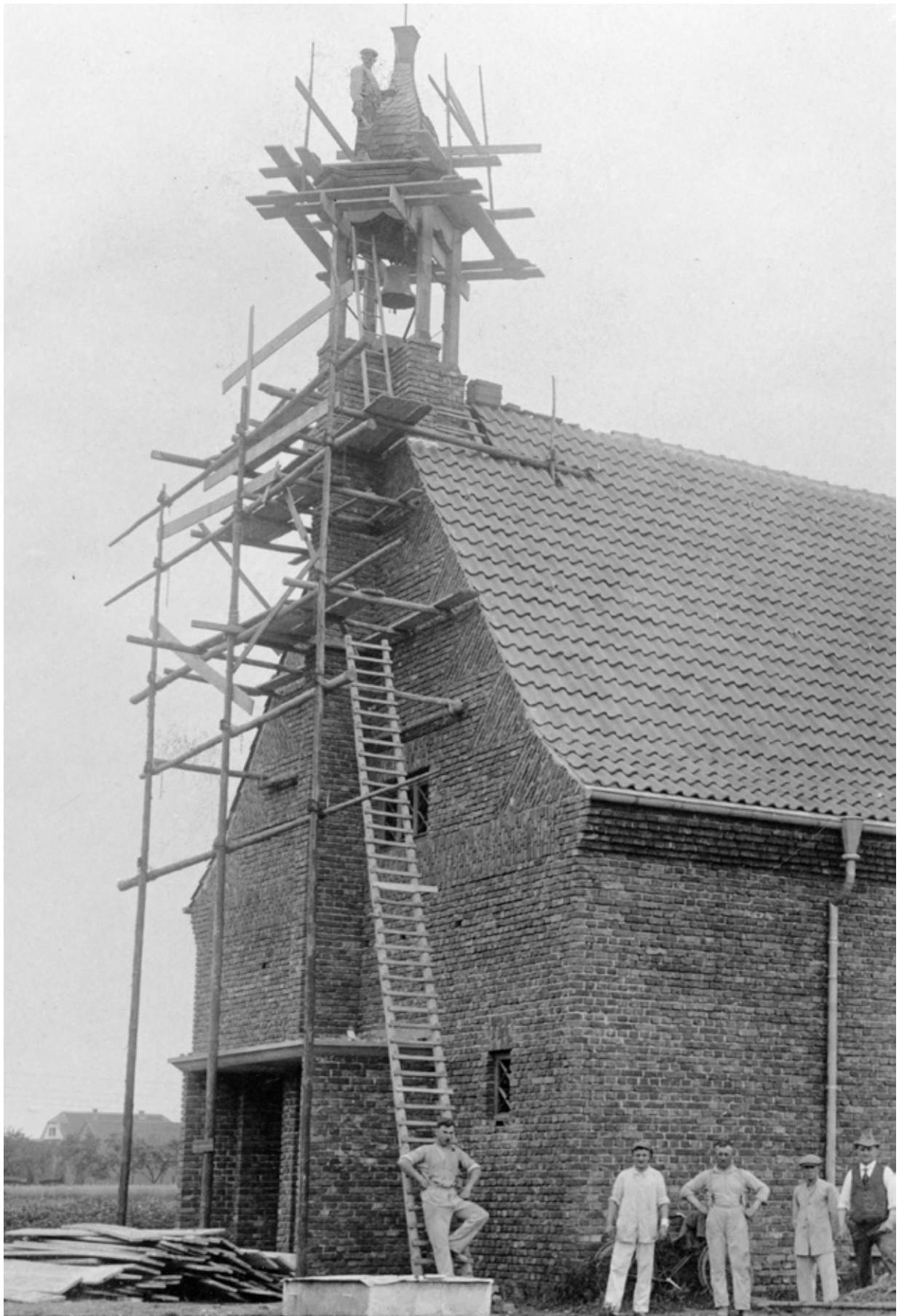
Abb. 8: Kirche St. Paulus, Berghausen (Langenfeld), 1926, Baustellenfoto - Unbekannt.
