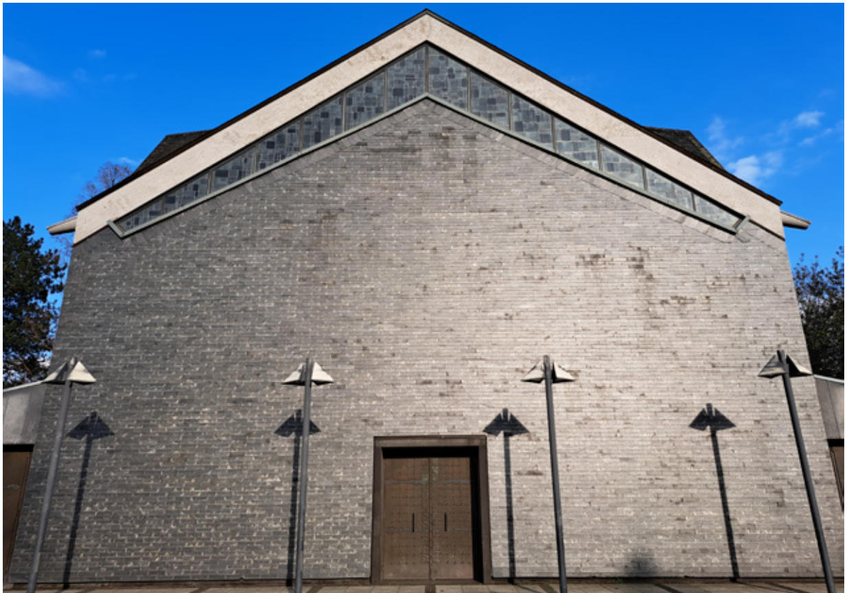
Abb. 33: Kirche Christus König, Langenfeld, 1963, Eingangsfassade - Stefan Knecht.
