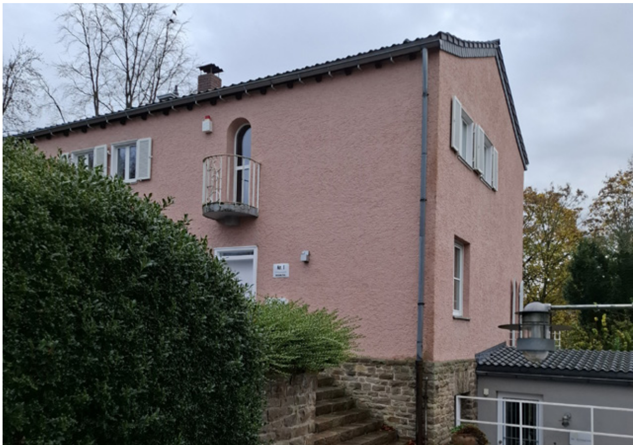
Abb. 86: Haus Rotterdam, Bensberg (Bergisch Gladbach), 1930, Straßenansicht - Stefan Knecht.
